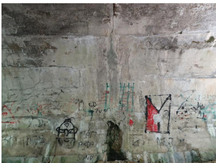
Foto č. 6 Konstrukce K 03 – líc střed nad O 02 degradovaný beton kolem pracovní spáry.
