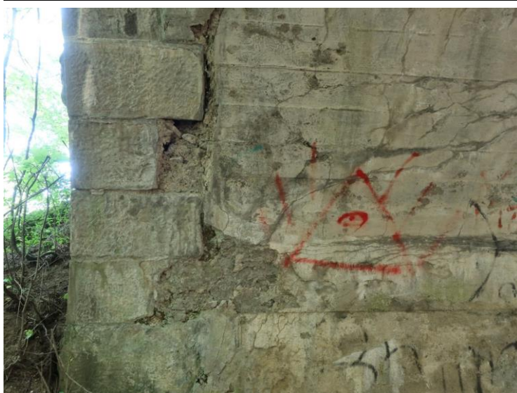
Foto č. 7 Konstrukce K 02 – lic nad O 02 vlevo, degradovaný beton, trhliny.
