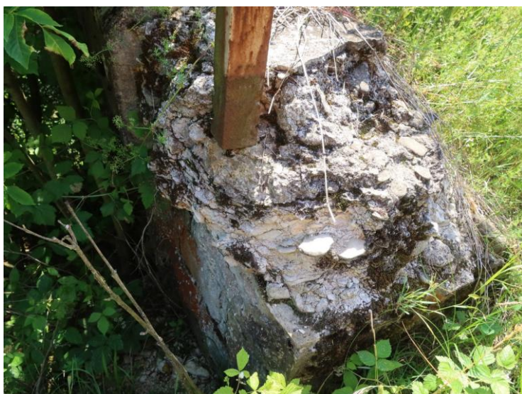
Foto č. 8 Opěra O 01 Křídlo vlevo, 1. sloupek, degradovaný beton
