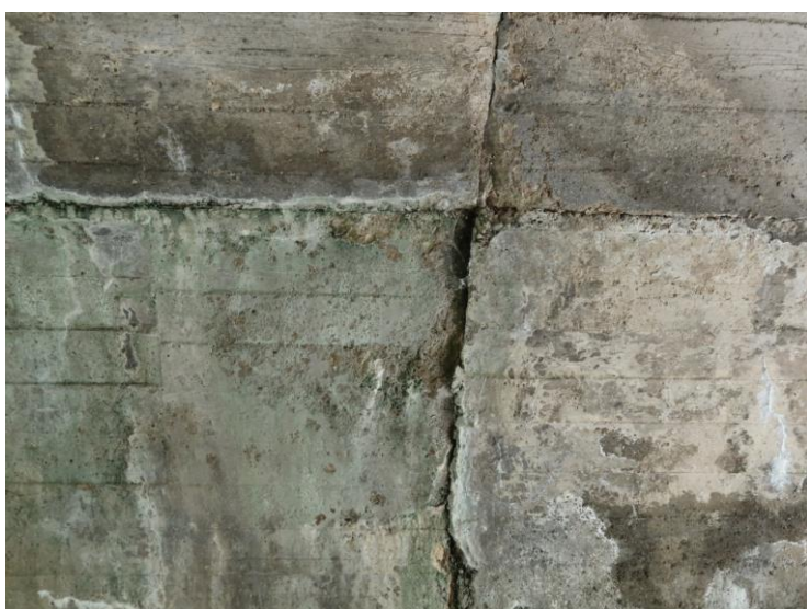
Foto č. 2 Konstrukce K 01 Lic dělící spára – vrchol degradovaný beton, trhлина.
