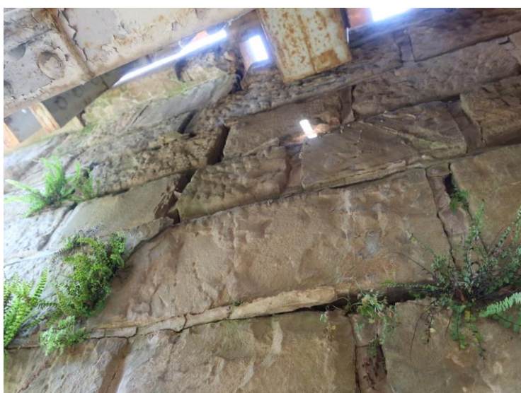
Foto č. 9 Pilíř P 01 2. otvor závěrná zeď vpravo – vydrolené spárování
