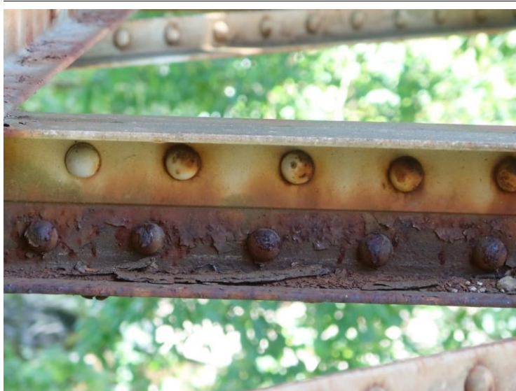
Foto č. 3 Konstrukce K 02 – 1. příčné ztužení vpravo korozní oslabení dolní pásnice.
