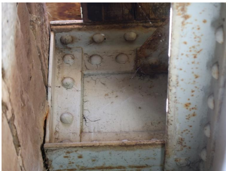
Foto č. 4 Konstrukce K 02 – pravý podélník nad P 02 naražení na závěrnou zeď
