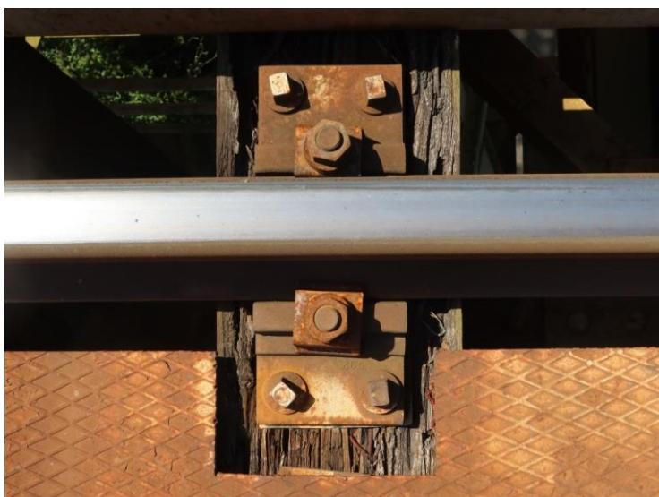
Foto č. 5 Konstrukce K 02 15. mostnice popraskaná, vyhnilá.
